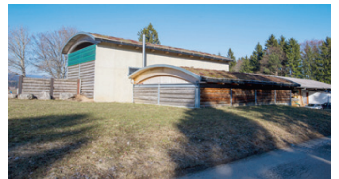
Les deux centrales de chauffage à distance de Bassins seront gérées par Romande Energie. SIGFREDO HARO
